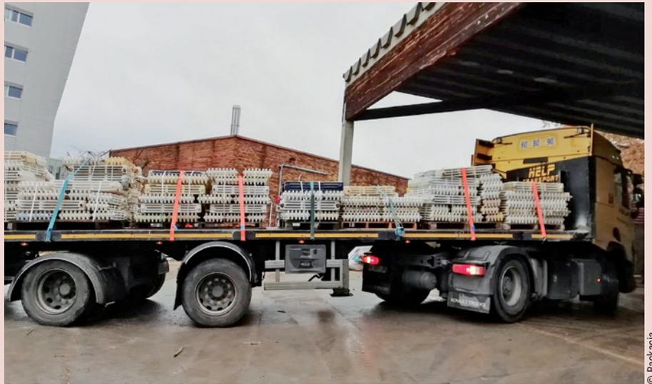
Réemploi des radiateurs en fonte de la Cité Gagarine à Ivry-sur-Seine
