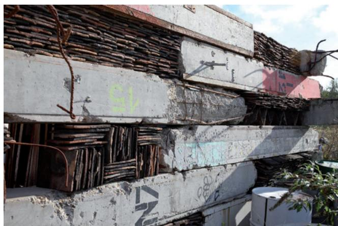
ActLab ; laboratoire de réemploi de l'association d'architectes de Bellastock - vue du mur avec réemploi matériaux de construction béton + tuiles
