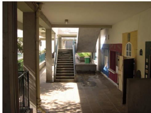
La pente du dallage et le système d'évacuation des eaux de pluie peuvent être défectueux.
