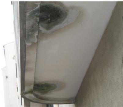
Les enduits en ciment et le béton non hydrofugé absorbent l'humidité et font apparaître des moisissures. Ici la dégradation est visible au niveau des appuis de fenêtres, corniches et balcons, non protégés par des habillages étanches.
