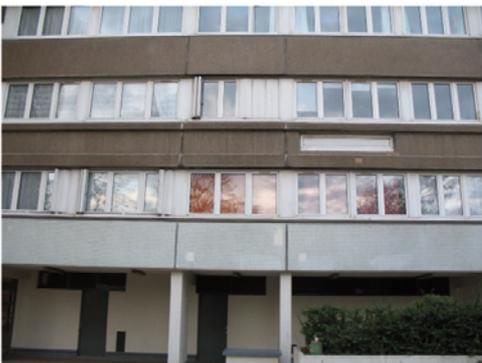
Les joints d'assemblage entre les panneaux préfabriqués sont source d'infiltrations et de ponts thermiques quand ils ne sont pas suffisamment entretenus.
