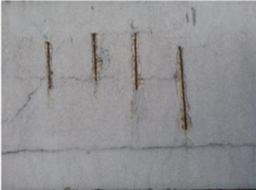
Les infiltrations d'eau dans les enrobage en béton abîment les ferrillages.
