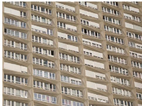
Les grands châssis ont tendance à se déformer plus vite et à se désolidariser de la façade, laissant des embrasures pour des infiltrations. Leur remplacement est onéreux. La forme sculpturale de certains panneaux peut rendre impossible l'isolation par l'extérieur.
